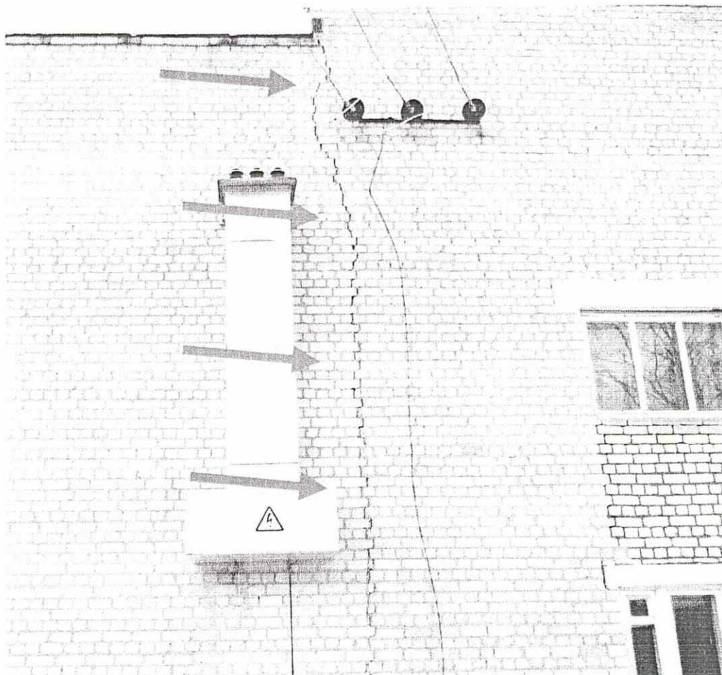
Фото 20. Трещина в кирпичной кладке по всей поверхности стены шириной раскрытия до 10 мм, протяженностью до 9000 мм, в осях «Г – В» / «1».
