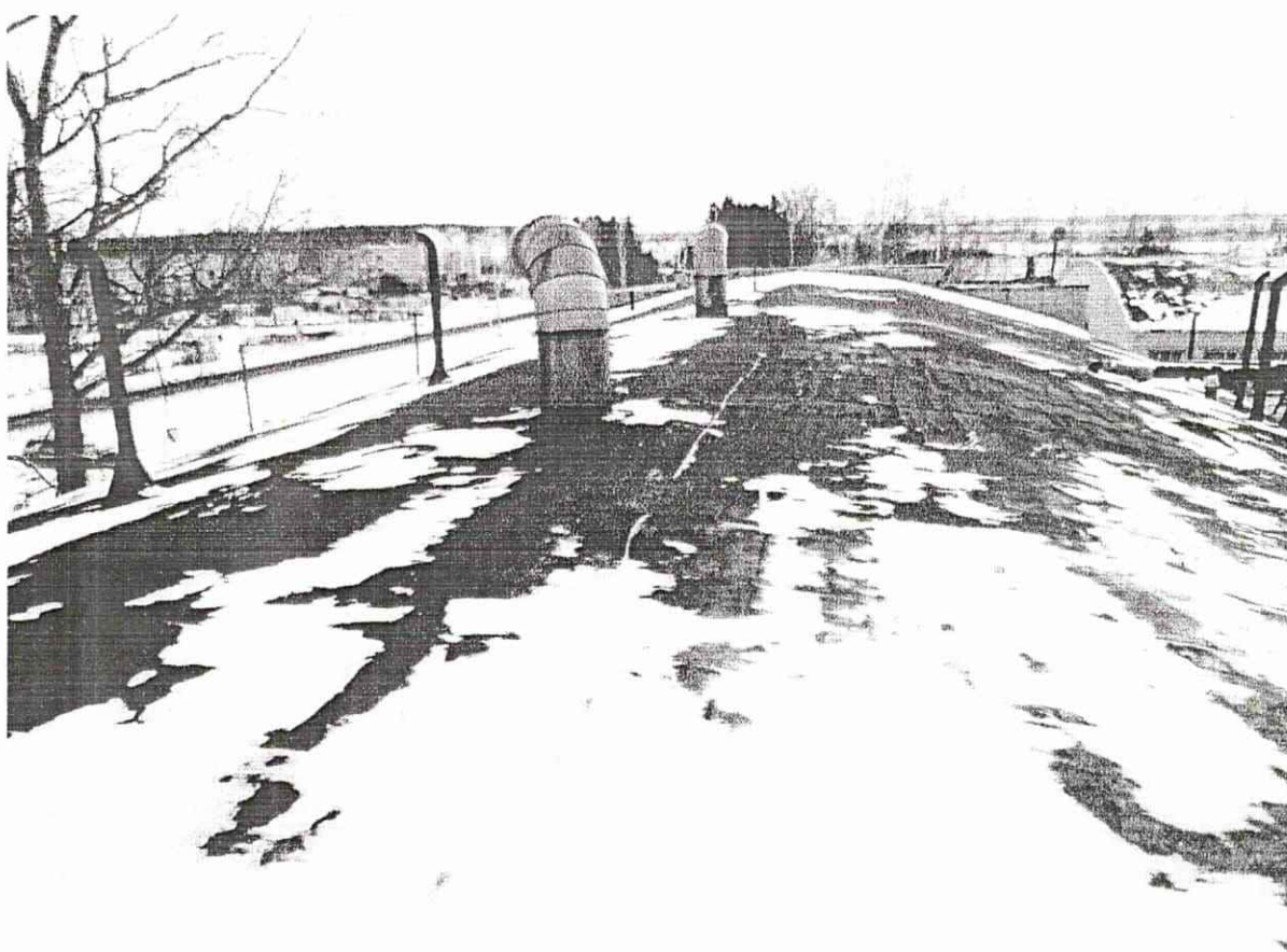
Фото 6. Общий вид кровли.
