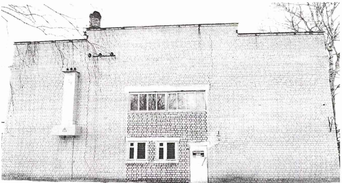
Фото 4. Фасад в осях «1» / «Г – А».
