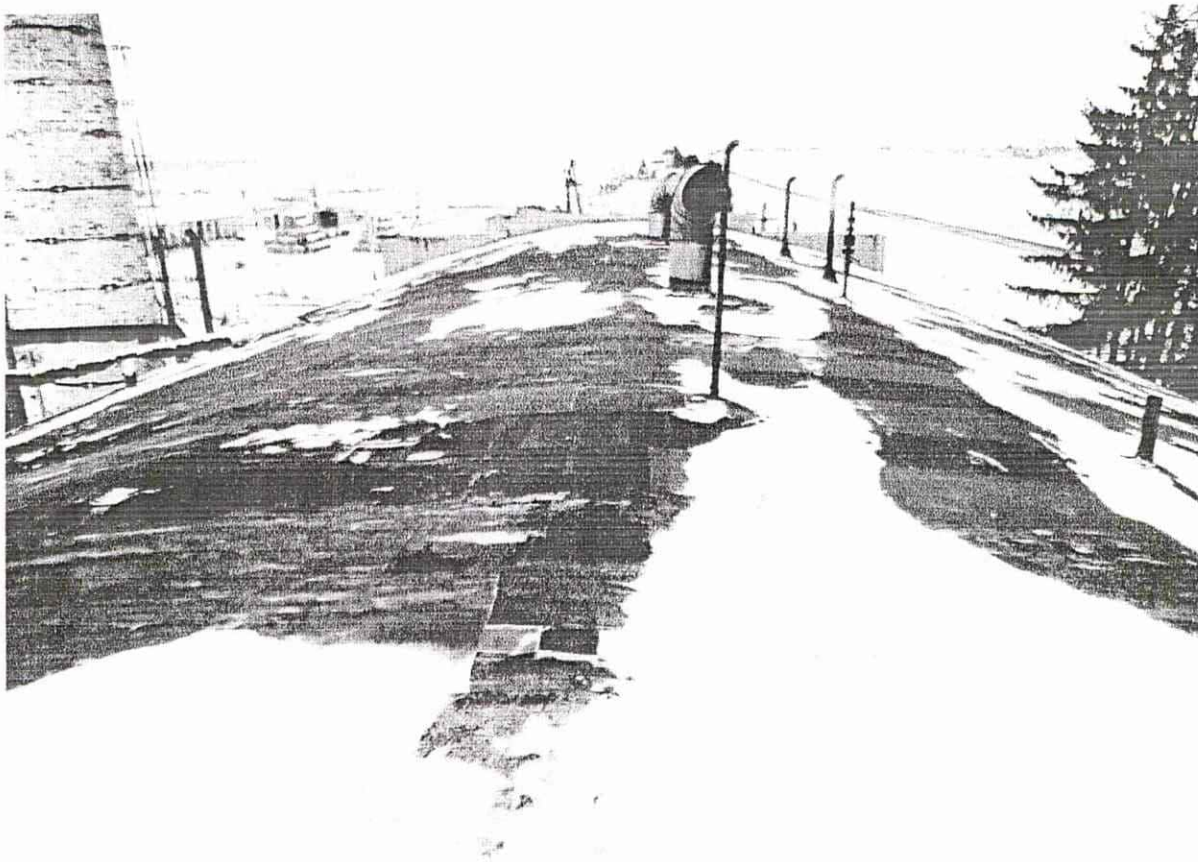
Фото 5. Общий вид кровли.
