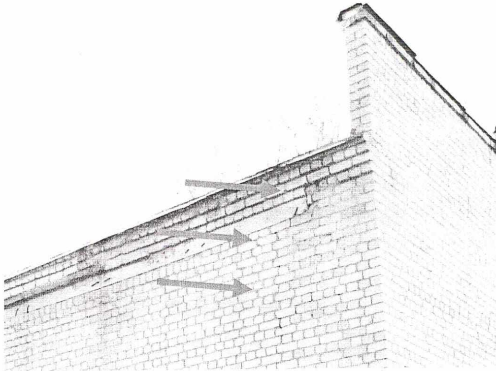
Фото 19. Трещина в кирпичной кладке шириной раскрытия до 3 мм, протяженностью до 1000 мм, в осях «1 – 2» / «Г».
