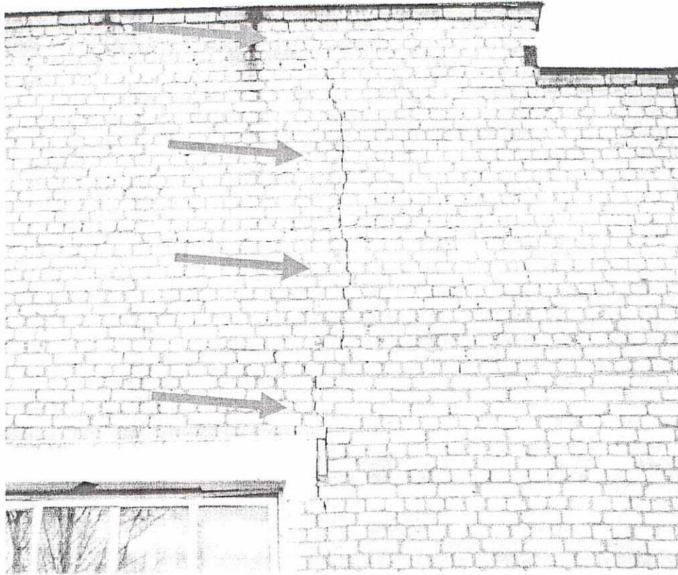
Фото 21. Трещина в кирпичной кладке шириной раскрытия до 6 мм, протяженностью до 5300 мм, выше оконного проема в осях «В – Б» / «1».
